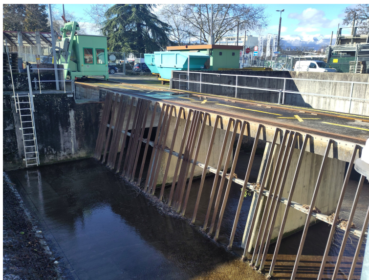
Figure 1.1 – Section en aval de la zone d'étude.
